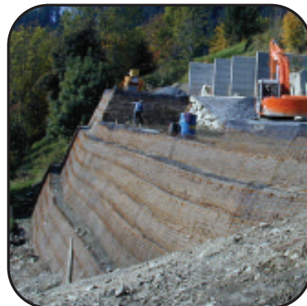
Zwitserland, Verbier: Keerwand met schanskorfconstructie, versterkt met Enkagrid PRO
