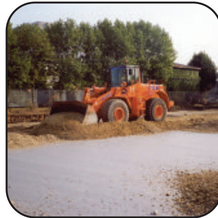
Frankrijk, Lyon: Grondstabilisatie bij constructie parkeerplaats (Enkagrid TRC 30)
