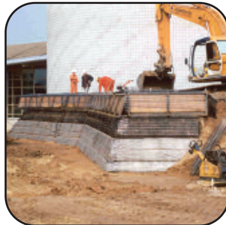
Nederland, Emmen: Steile helling met daarin Enkagrid PRO en Enkamat 7210
