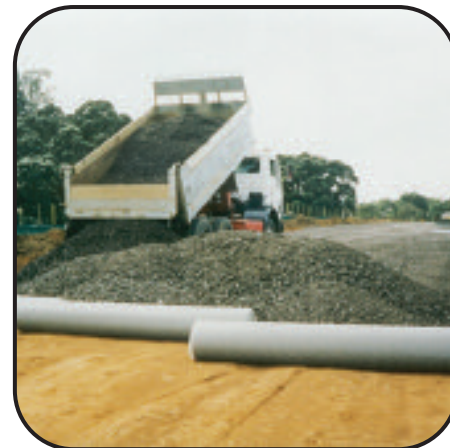
Nieuw Zeeland, Auckland: Constructie van bouwweg met Enkagrid TRC 30
