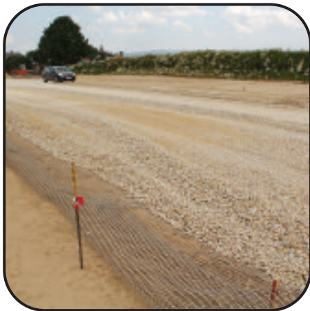
Polen, Żywiec: Stabilisatie van de ondergrond (Enkagrid MAX)
